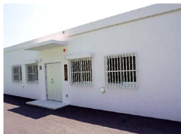
勝連運動場管理棟
