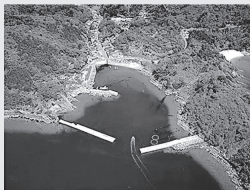
〈狐崎漁港(石巻市)〉 (宮城県公式ウェブサイト) より
